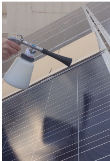
Εφαρμογή του SurfaShield G με σύστημα εκνέφωσης Tornador της εταιρίας Bendel.
