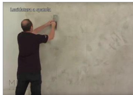
Βήμα 6 – Για να αποκτήσετε περισσότερη γυαλάδα, όταν το προϊόν δείχνει στεγνό, πατήστε ξανά με την σπάτουλα. Για προστασία και για την ανάλογη διαπνοή και προστασία εφαρμόστε, Savon d'eau ;h Cera del vechio, ή Vetro Lucido/Opaco
