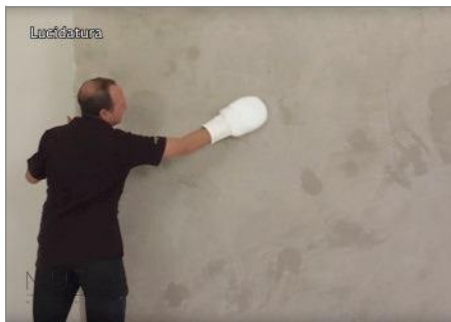
Βήμα 5 – Όταν η επιφάνεια αρχίζει να στεγνώνει (μικρές σκιές) γυαλίστε την με την χρήση του γαντιού PE6
